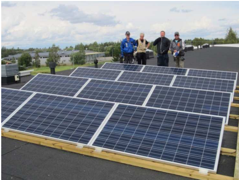
Kokemäen Sähkön aurinkopaneelijärjestelmän asennusporukka asennuksen jälkeen 14.8.2014.
